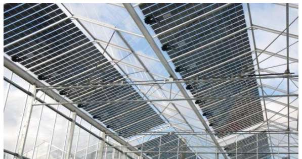
Zonnepanelen verwerkt bij kassen
