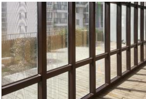
Zonnepanelen verwerkt in ramen van een gebouw
