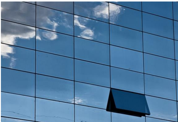
Zonnepanelen verwerkt in glazen wand kantoorgebouw
