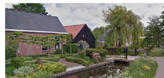
discontinuïteit van de watergang door de plaatsing van hekwerken op de brug
