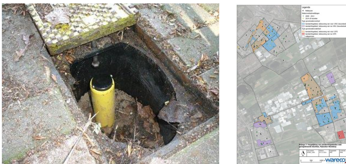
Figuur 6-2 Bestaande peilbuis en het meetnet binnen de gemeente
