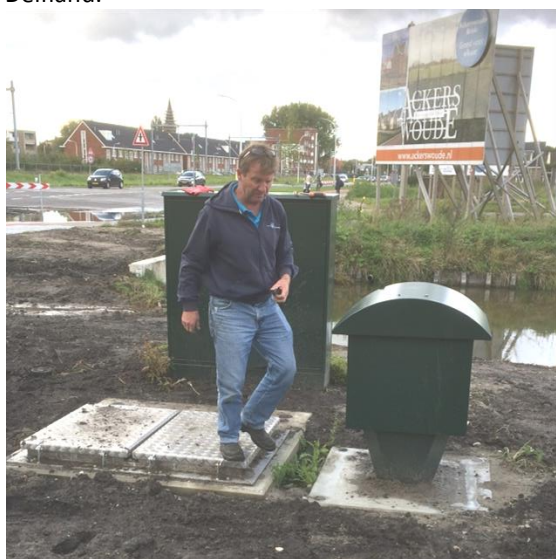
Figuur 6-1 Een nieuw rioolgemaal, bijna klaar voor oplevering.
